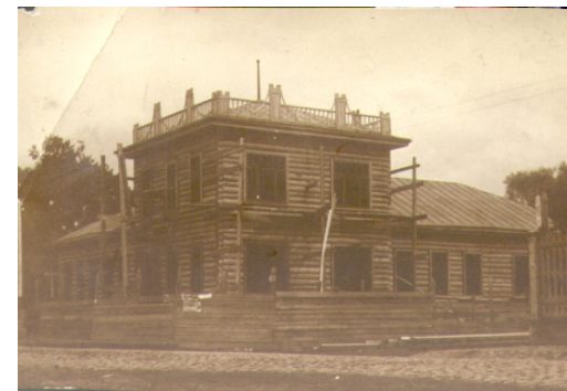
Строительство дома врача М.П.Глинки. Старая Русса, 1912
