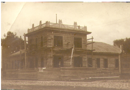
Строительство дома врача М.П.Глинки. Старая Русса, 1912
